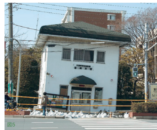
5: 東日本大震災による液状化被害。液状化により泥水が噴出、地盤沈下に伴い交番が傾斜した。| 6: 液状化現象のメカニズム。
