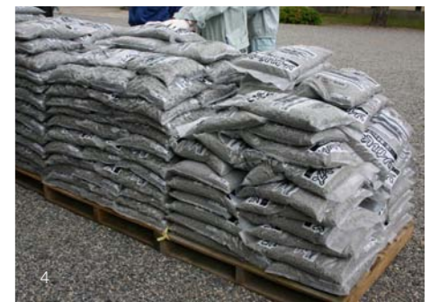
1: スライド以前の素屋根内部。手前の床も共に移動する 2: 素屋根スライドセレモニーに集まった3,000人を超す見学者たち 3: 地元大手印刷製版メーカーと共同開発した瓦記名印刷機 4: 廃瓦と葺土から調湿建材をタイルメーカーと共同開発
