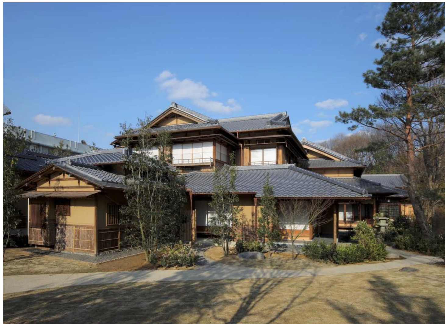
移築・改修後の光雲荘。婦人客間側の外観(本施設はパナソニック社内の研修施設として移築されたもので、一般公開はされていません)
