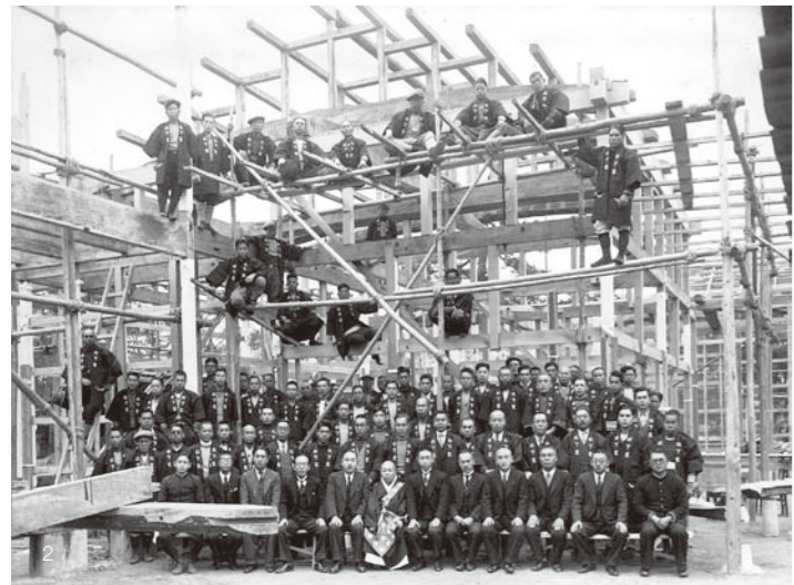
1: 西宮での移築工事の様子。書斎・主人間の小屋組が見えているところ 2: 1937(昭和12)年の本家上棟式時の写真
