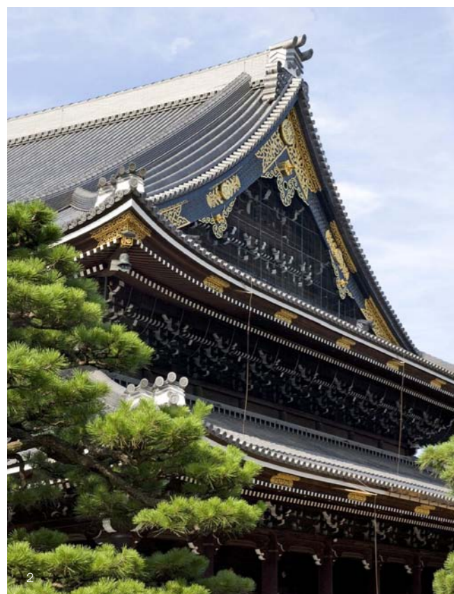
1: 梅酢と活性水により美掃修理された内陣本間の須弥壇・厨子 2・3: 漆金箔により当時の輝きを取り戻した外部の鍍金物 写真: © 柄谷 稔 (p.3[上], 5, 6[4], 8)
