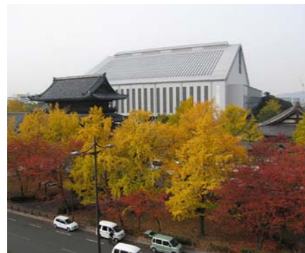
修復中の御影堂の素屋根と境内の紅葉
