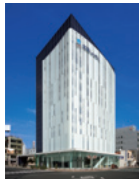
南側ダブルスキン乳白ガラスの外皮と太陽光発電電池
