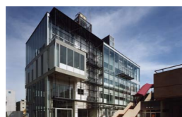
関東学院大学環境共生技術 フロンティアセンター その他ビル部門 審査委員会奨励賞
