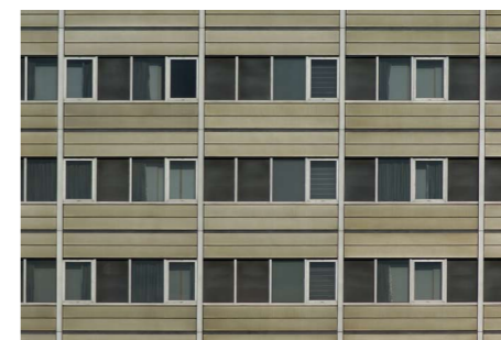
改修前の外装(アルミカーテンウォール)
