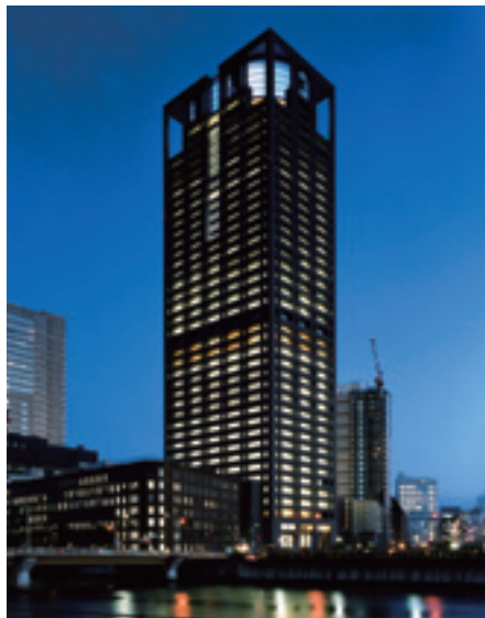
関電ビルディング/環境共生のモデルビルの実践 第45回空気調和・衛生工学会賞 (社)空気調和・衛生工学会 建築設備部門 技術賞
