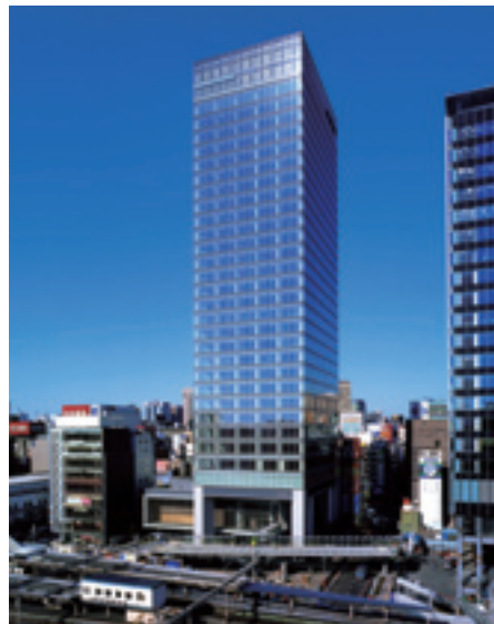
秋葉原ダイビルにおける氷蓄熱の運用と 大温度差搬送システム 第21回空気調和・衛生工学会振興賞 (社)空気調和・衛生工学会 技術振興賞
