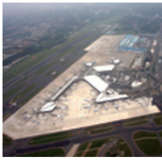
成田国際空港 第一旅客ターミナルビル 第3回日本建築家協会優秀建築選 (社)日本建築家協会
