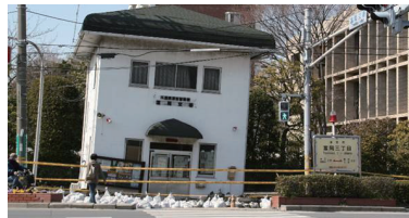
液状化により傾いた建物
