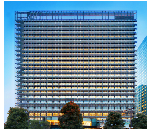
バイオスキンで大型建築と環境をつなぐ： NBF 大崎ビル 写真：野田東徳 / 雁光舎
