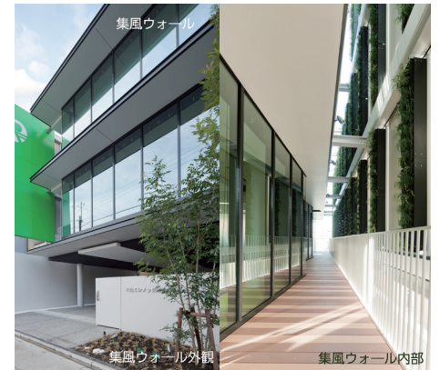
<PCM活用ソーラーチムニー> PCMの調温効果により夜間の浮力換気を促進
