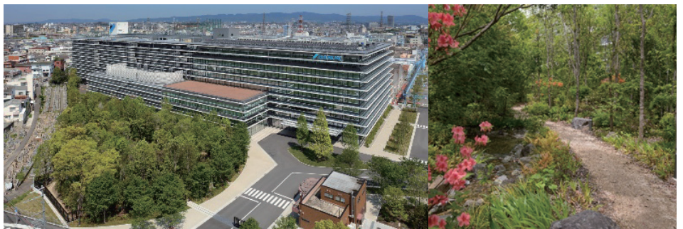
敷地のセキュリティラインを変更し、周辺住民が森を利用できるようにしている。 TICの森：ダイキン工業テクノロジー・イノベーションセンター（2015年）写真 | (左) SS Co., Ltd. (右) Kouzan Shimizu
