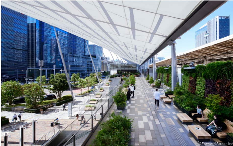
図5. 改修後のグランルーフ2階「GRANROOF GARDEN」の様子
